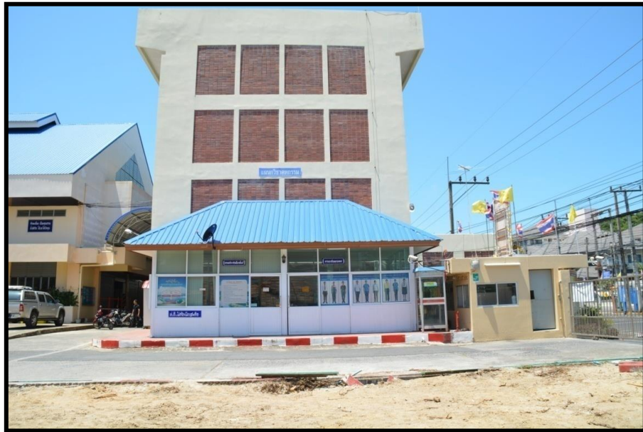
ภาพที่ 1 อาคาร 3 อาคารเรียน
